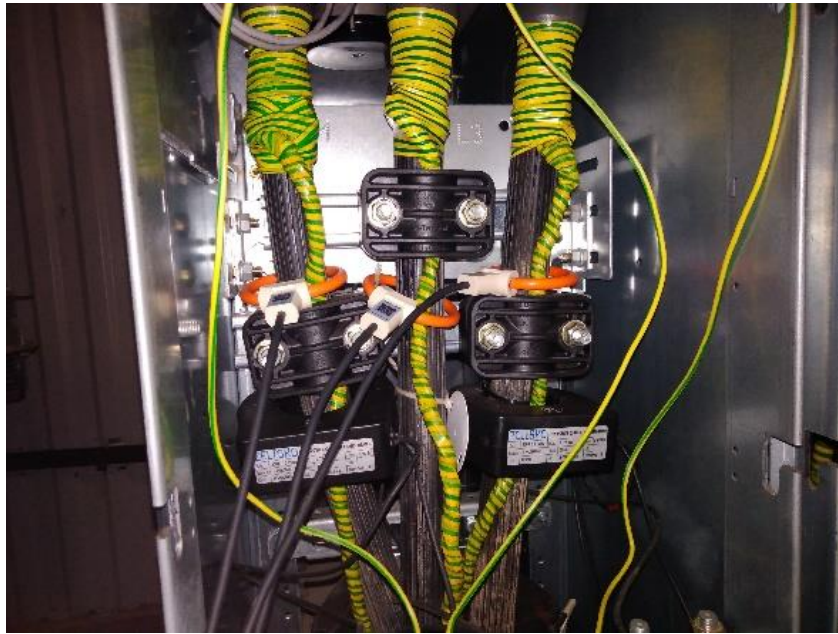
Рисунок 2.3 – Пример установки ДТ в ячейке КРУ
