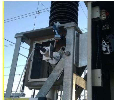
*Цифровой вращающийся преобразователь установленный наверху высоковольтного элегазового выключателя ABB LTB 245 кВ*
