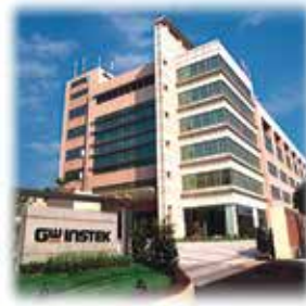
Штаб квартира и фабрика, Тайвань
