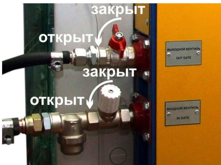
Рис.7. Положение входного/выходного вентилей
