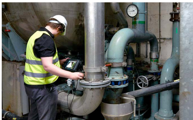
Инспекция промышленного трубопровода с помощью дефектоскопа Proceq Flaw Detector 100
