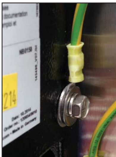
Рис. 3 Шпилька заземления с гайками и шайбами в сборе
