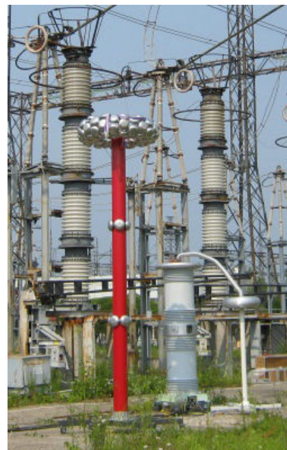
Делитель напряжения ДН-500пт
