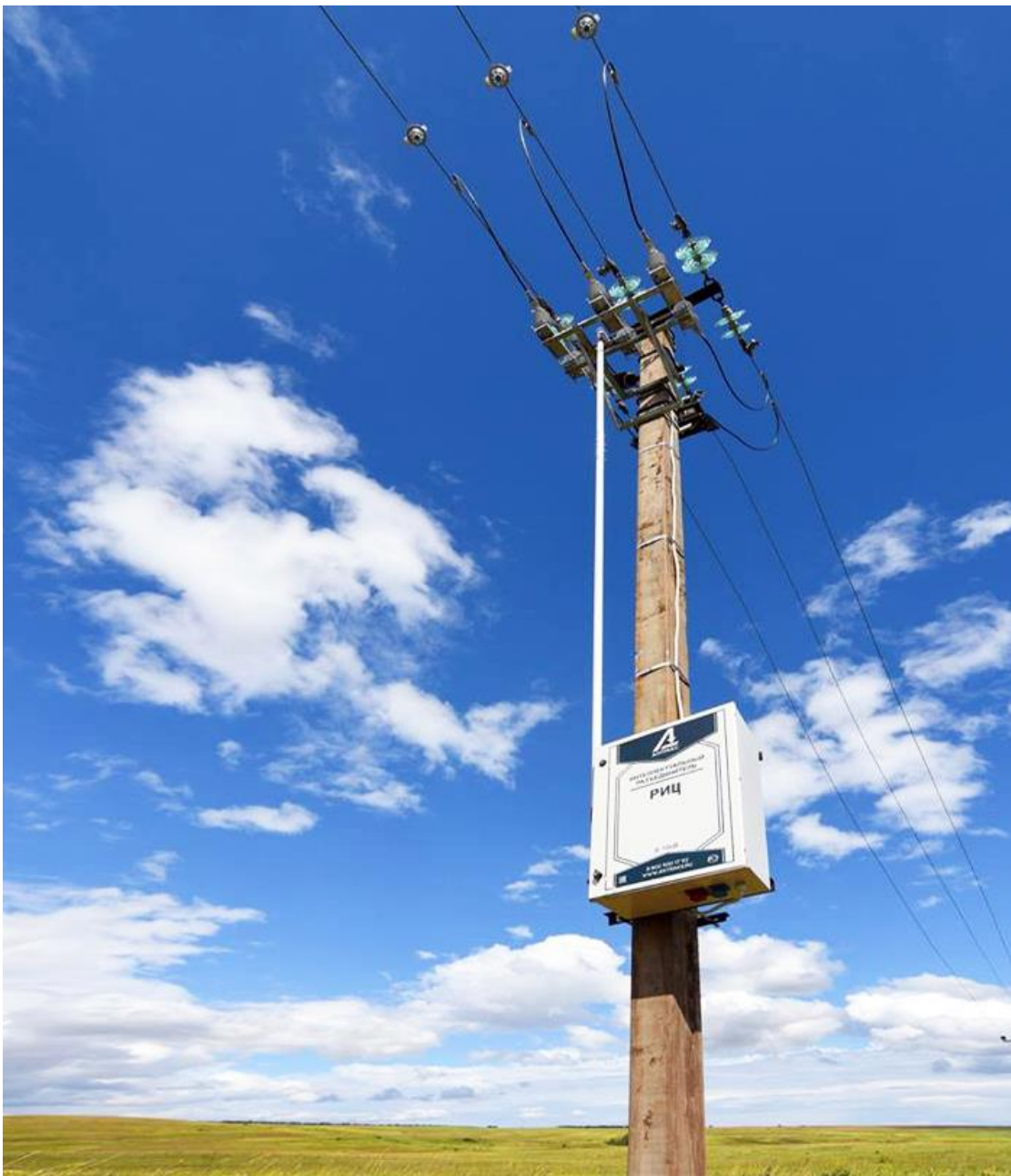
Рисунок 6 - Пример установки интеллектуального разъединителя РИЦ
