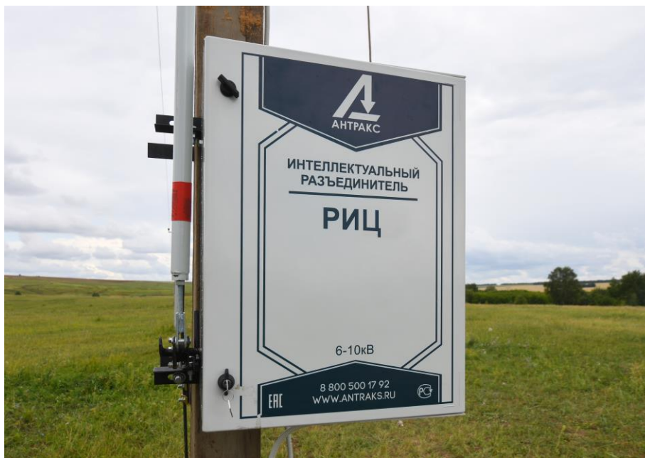
Рисунок 1 – Внешний вид внешнего шкафа управления с приводом с закрытой дверцей
